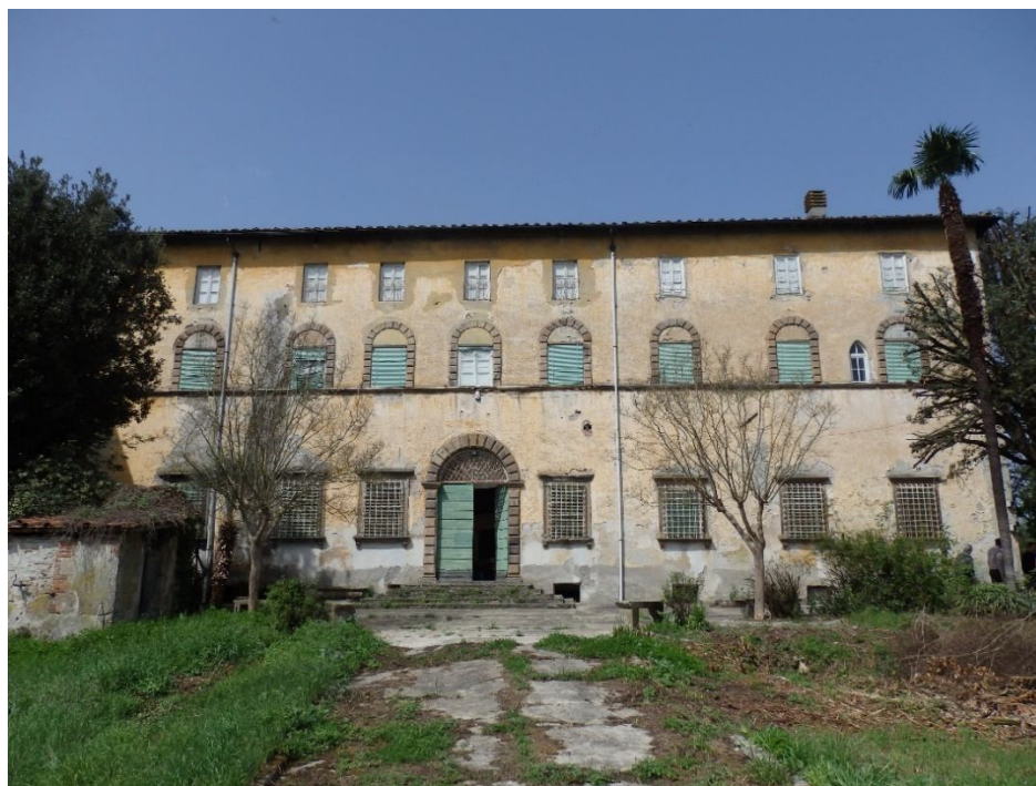
Vicopelago (Lucca). Monastero S. Agostino. Prospetto orientale (immagini realizzate nel maggio 2018).
